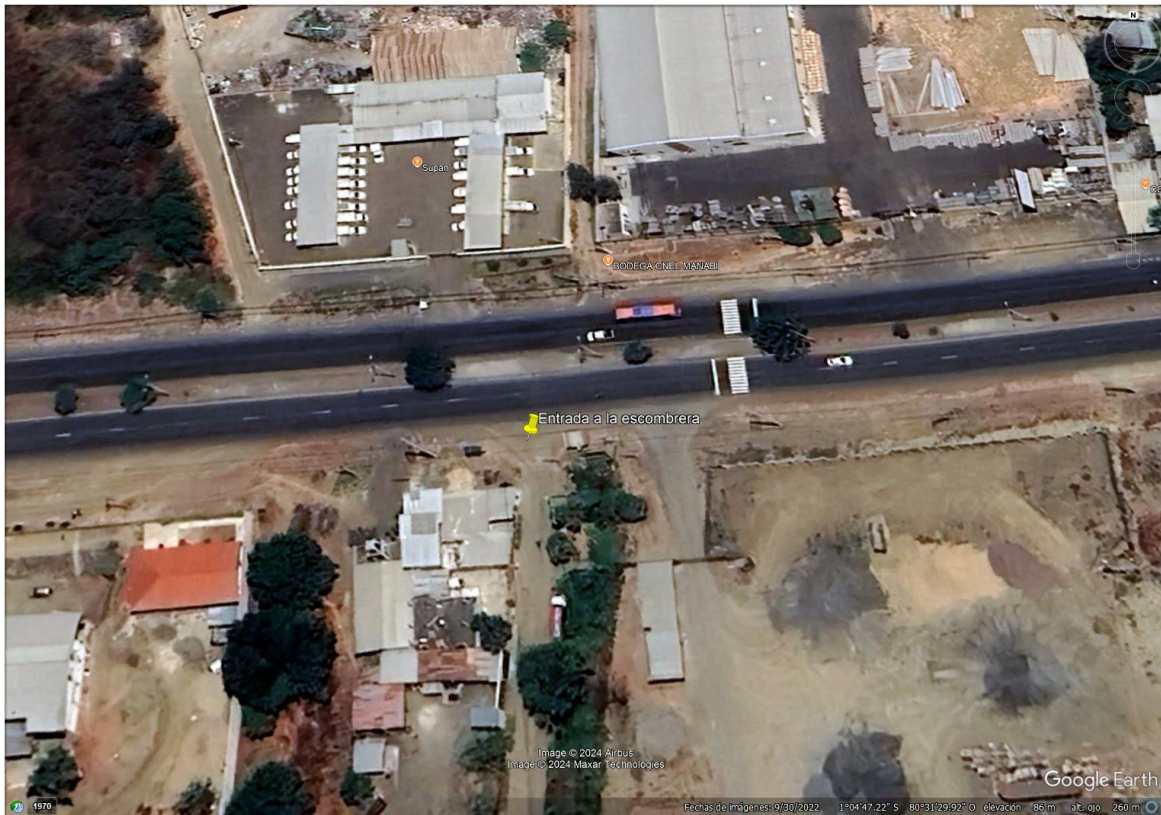
Figura 1 Vista satelital de la entrada de la escombrera.
